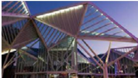
El pabellón se compone de un conjunto de veintitrés módulos iguales e inversos, que juntos forman una malla estructural.
